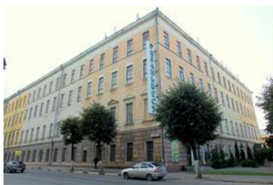
Рисунок 1 – Здание Рязанских присутственных мест. Соборная площадь, д.21
