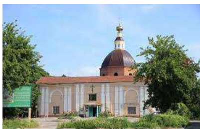
Рисунок 3 – Староямская Никольская церковь. Ул. Николодворянская, д. 12
